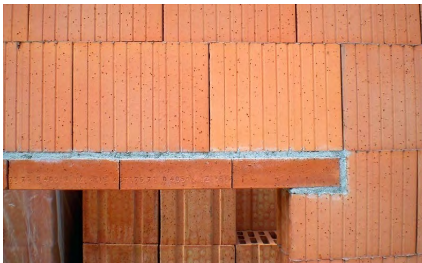
Slika – pravilna vzdava opečne preklade
