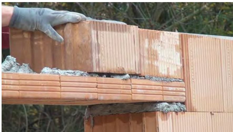
Slika – pravilna vzdava opečne preklade
